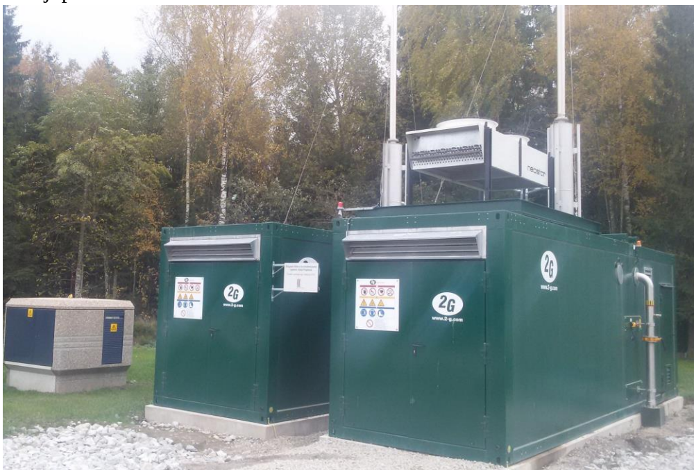
Ekovir OÜ Uikala prügila saasteallikas – koostootmisjaam KTJ
