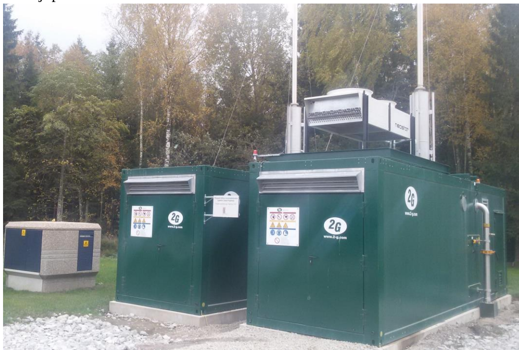
Ekovir OÜ Uikala prügila saasteallikas – koostootmisjaam KTJ
